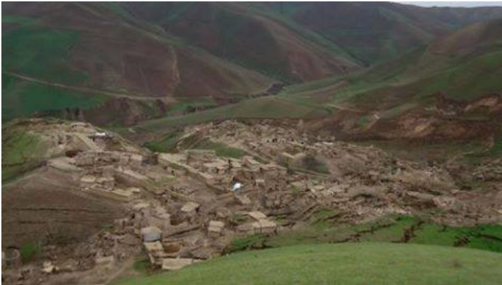
ویرانه های غم انگیزناشی از زلزله رستاق
